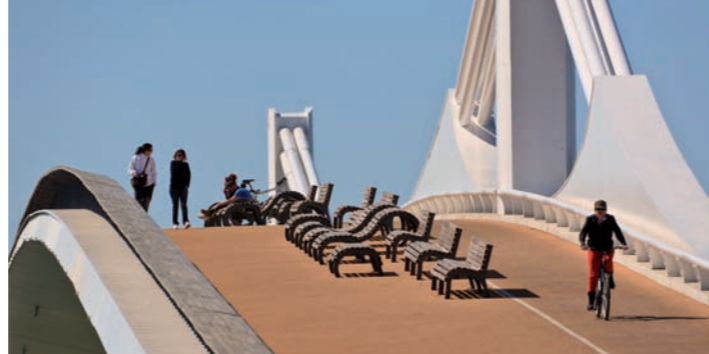
4 Lo Passador Bridge
