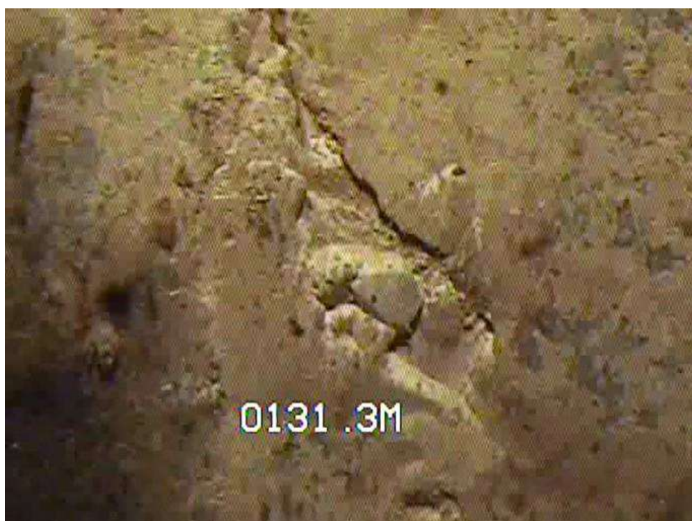
Figura 14. Visió lateral. Possible descamació superficial de la pàtina d'incrustacions.
