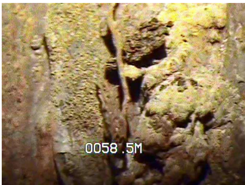
Figura 10. Visió lateral. Detall d'incrustació adherida a la canonada de revestiment.
