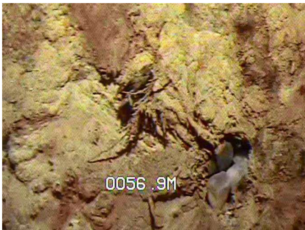
Figura 9. Visió lateral. Detall de forat de petita mida (2-4 cm) a la canonada de revestiment. S'observen graves a través del mateix.
