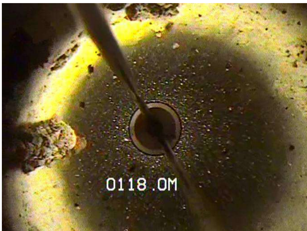
Figura 13. Visió axial. Incrustacions adherides a la canonada de revestiment.
