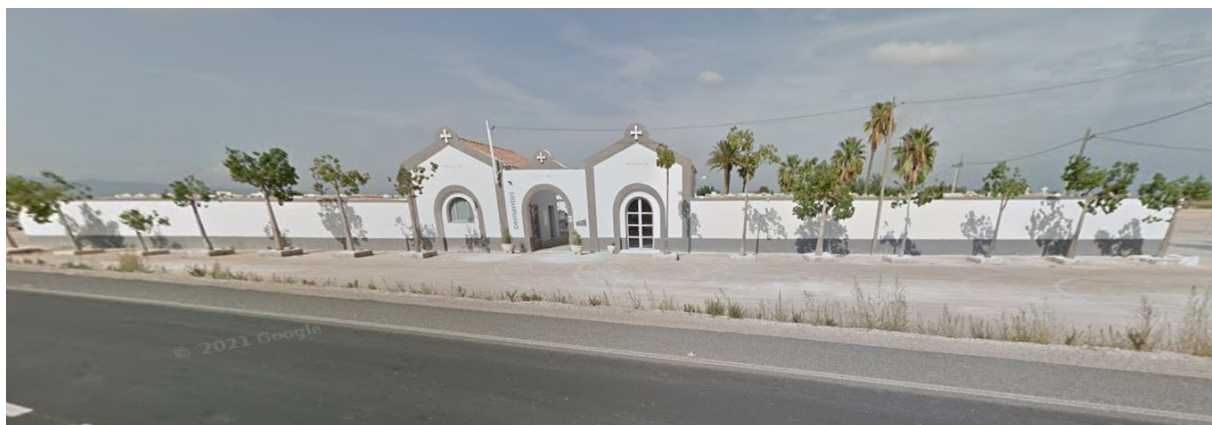
Imatge del mur perimetral delimitador de l'equipament
