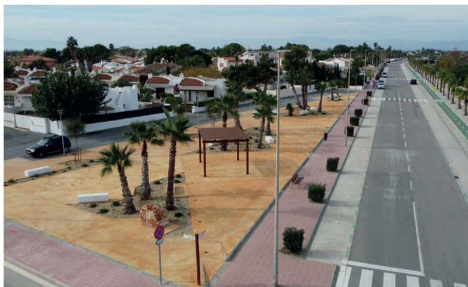
Vista aèria de la plaça dels Vents
