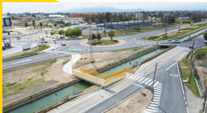
~ Passarel·la d'accés per a vianants
