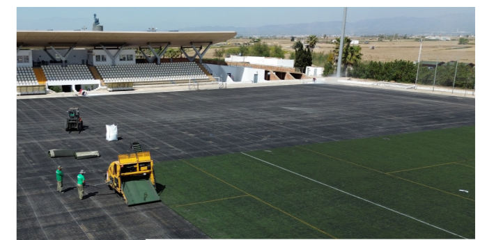
Els equips de treball executant el canvi de gespa artificial al Camp Nou
