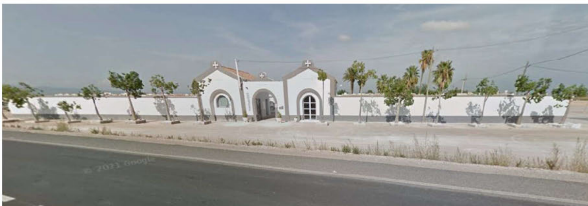
Imatge del mur perimetral delimitador de l'equipament
